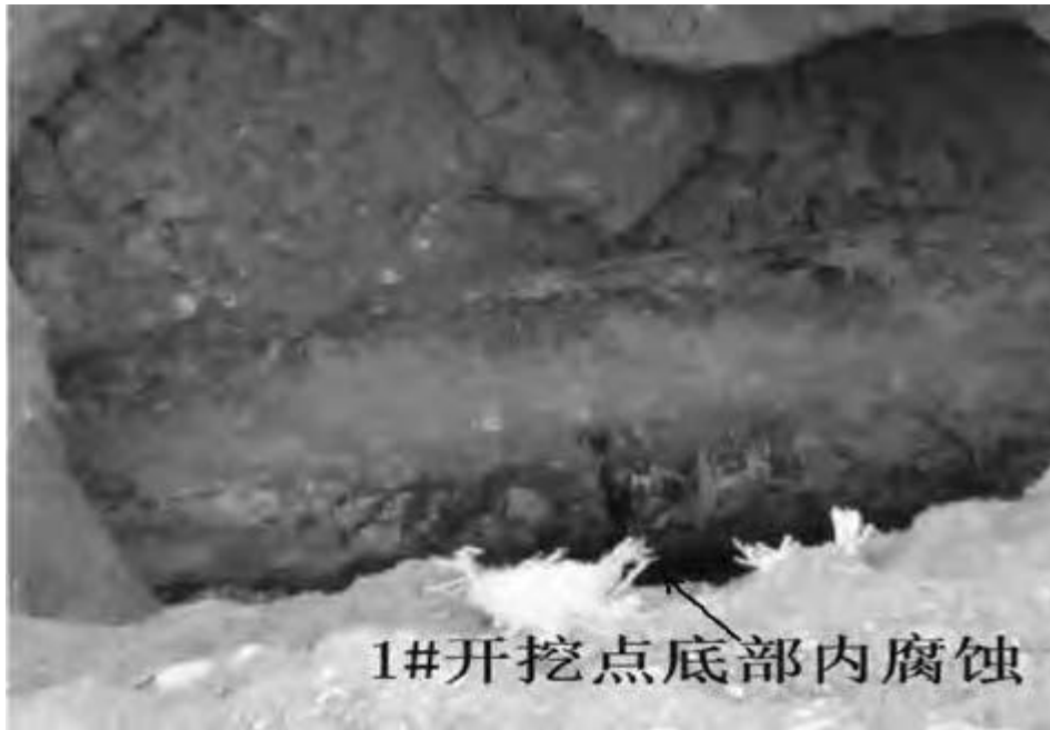
图6 1# 开挖点现场照片
